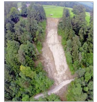
Unpassierbar Unwetterschäden bei der Hergiswaldstrasse.
